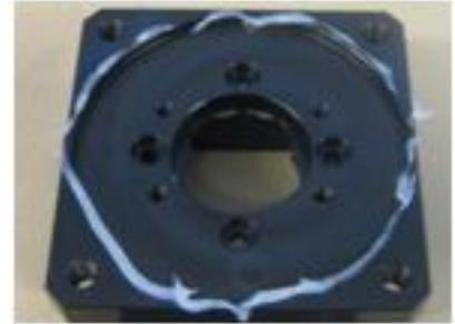
Abbildung 31: Flansch für IP65 vorbereitet
